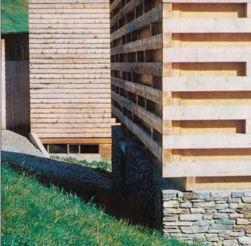
Ils materials indigen han prioritad tier la construcziun dils objects digl architect reconuschiu.
